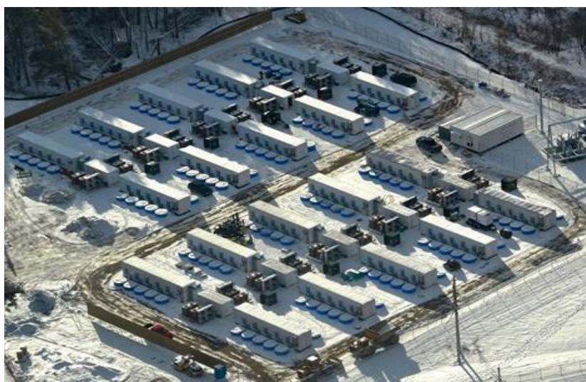
Figura 16 - Central de armazenamento de Beacon Power's com volantes de inércia em Stephentown, New York, com 2 MW (40 volantes de inércia de 500kW) e 5MWh para controlo de frequência.
