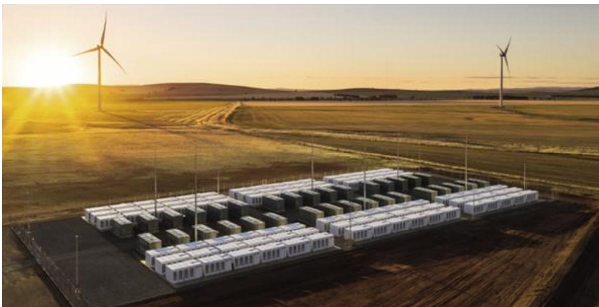
*Figura 18 - Central de armazenamento de baterias de ião de lítio Hornsdale, Austrália, com 100 MW/129 MWh, para controlo de frequência.*
